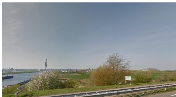
Zicht op Koningspleij-Noord van Pleijroute
